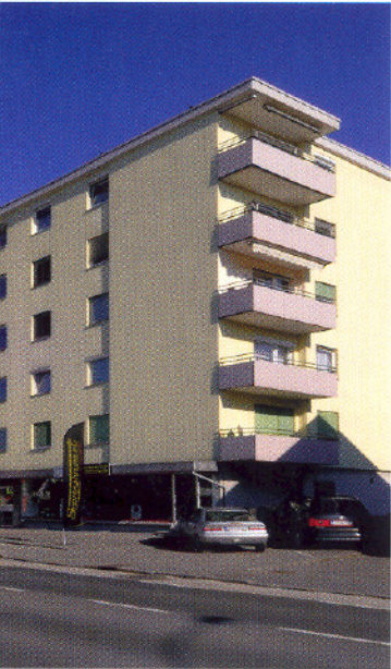
Das Mehrfamilienhaus im Vorarlberger Lustenau wurde 1966 mit einem Polystyrol-basierten WDVS versehen. In den vergangenen viereinhalb Jahrzehnten war lediglich ein Renovationsanstrich nötig, um die uneingeschränkte Funktionsfähigkeit zu erhalten. © Günter Laznia, Bregenz, AT
