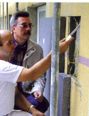
Im Zuge einer Aufdoppelung wird das bestehende Wärmedämm-Verbundsystem zur Beurteilung der Standsicherheit an repräsentativen Stellen geöffnet.
